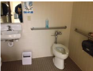
ADA Toilet Room
